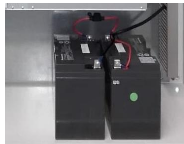
Abb. 6: Batterien positionieren
