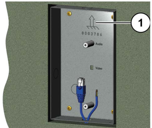
Abb. 3: Einbau des Unterputzkastens
