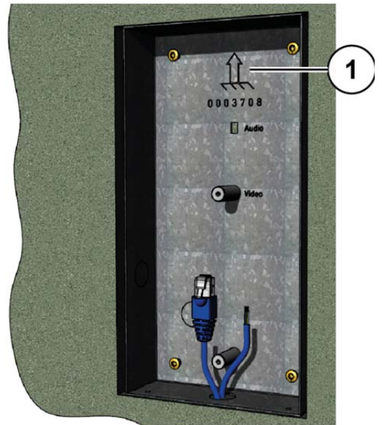
Abb. 3: Einbau des Unterputzkastens
